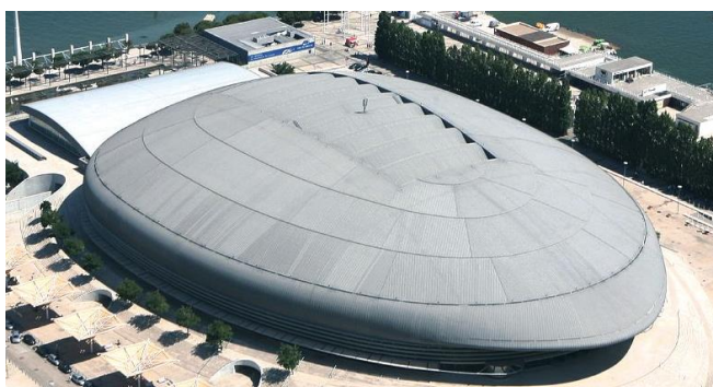
Fig. 2 MEO Arena roof
